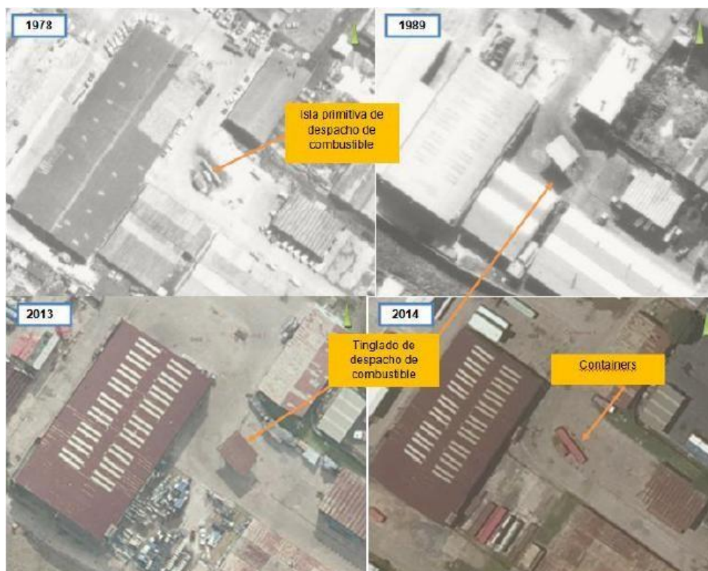
Ilustración 20: Vista del SASH a través del tiempo 1978-2014
