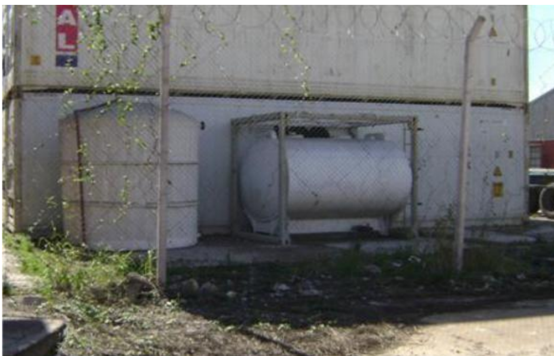
Ilustración 35: Tanques sobre la ex imprenta
