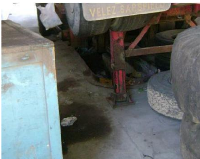
Ilustración 16: Manchas en piso entre fosas del lavadero
