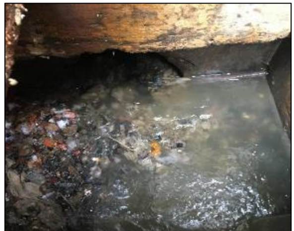
Obtención de desagües existentes
