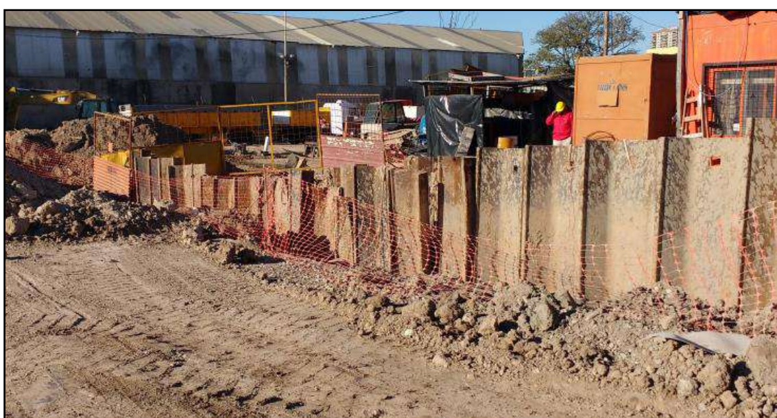
Imagen 20: Excavación Entibado
