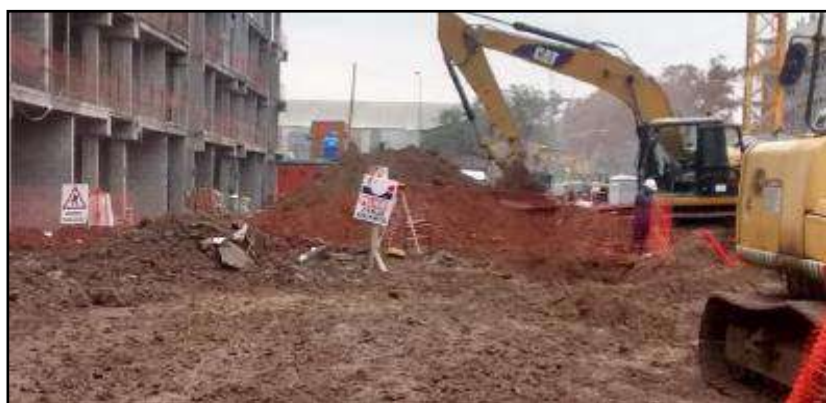
Imagen 19: Excavación- señalización
