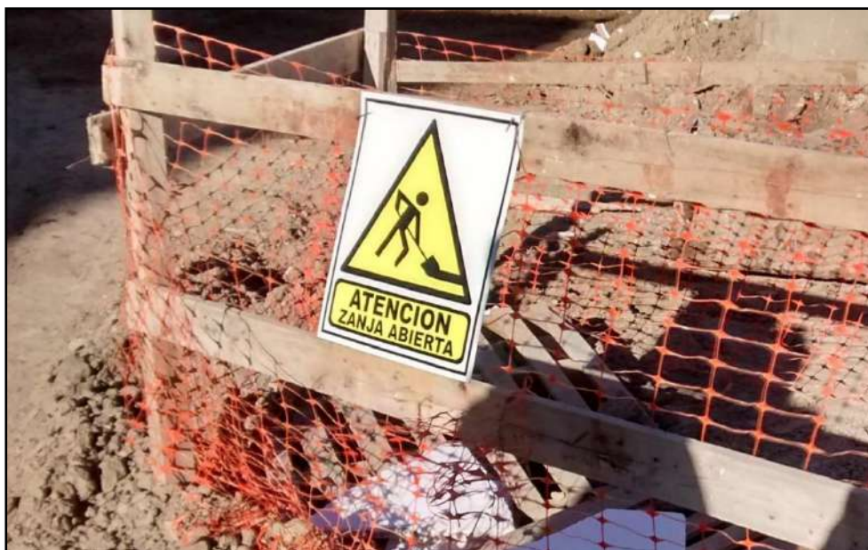
Imagen 18 : Señalización Zanja Abierta
