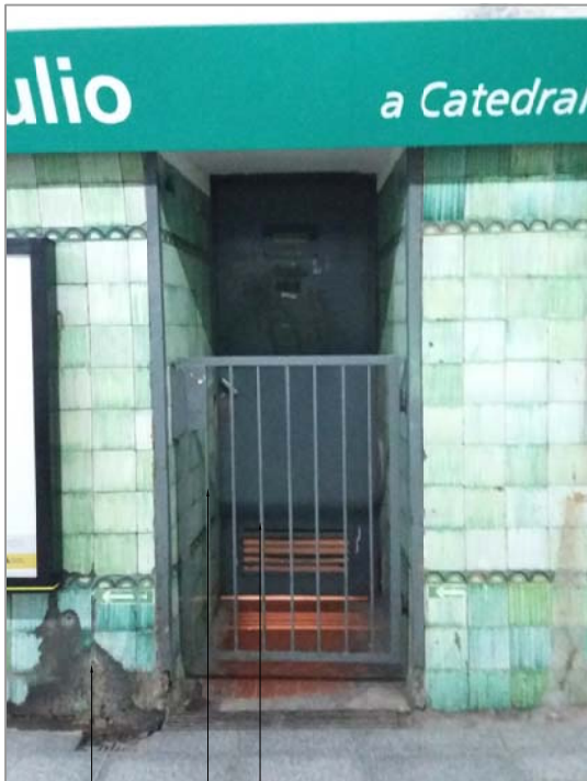
PUERTA, PERFILES, SOLADO, REVESTIMIENTO, CIELORRASO Y REJA EXISTENTES A DESMONTAR AMPLIACIÓN DE VANO EXISTENTE MAYOLICAS EXISTENTES A COMPLETAR
