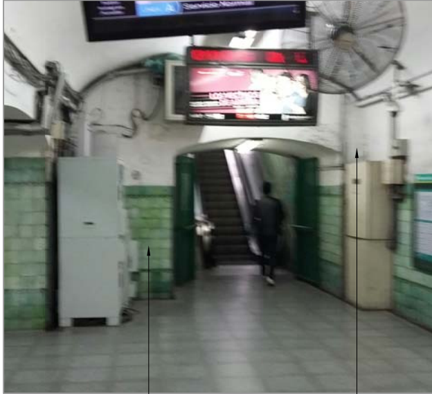
MURO EXISTENTE A DEMOLER A ANCHO IDEM MOCHETA EXISTENTE
