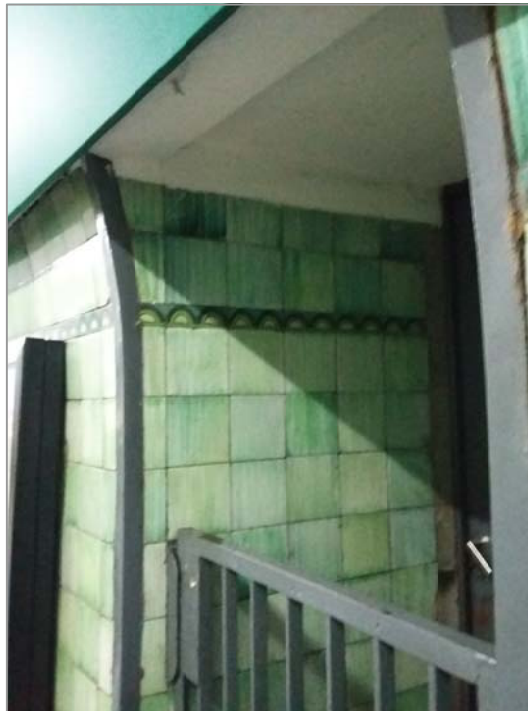
PUERTA, PERFILES, SOLADO, REVESTIMIENTO, CIELORRASO Y REJA EXISTENTES A DESMONTAR AMPLIACIÓN DE VANO EXISTENTE MAYOLICAS EXISTENTES A COMPLETAR
