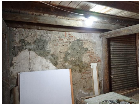
MESANINES EN MADERA EXISTENTES EN EL NÚCLEO BÁSICO.
