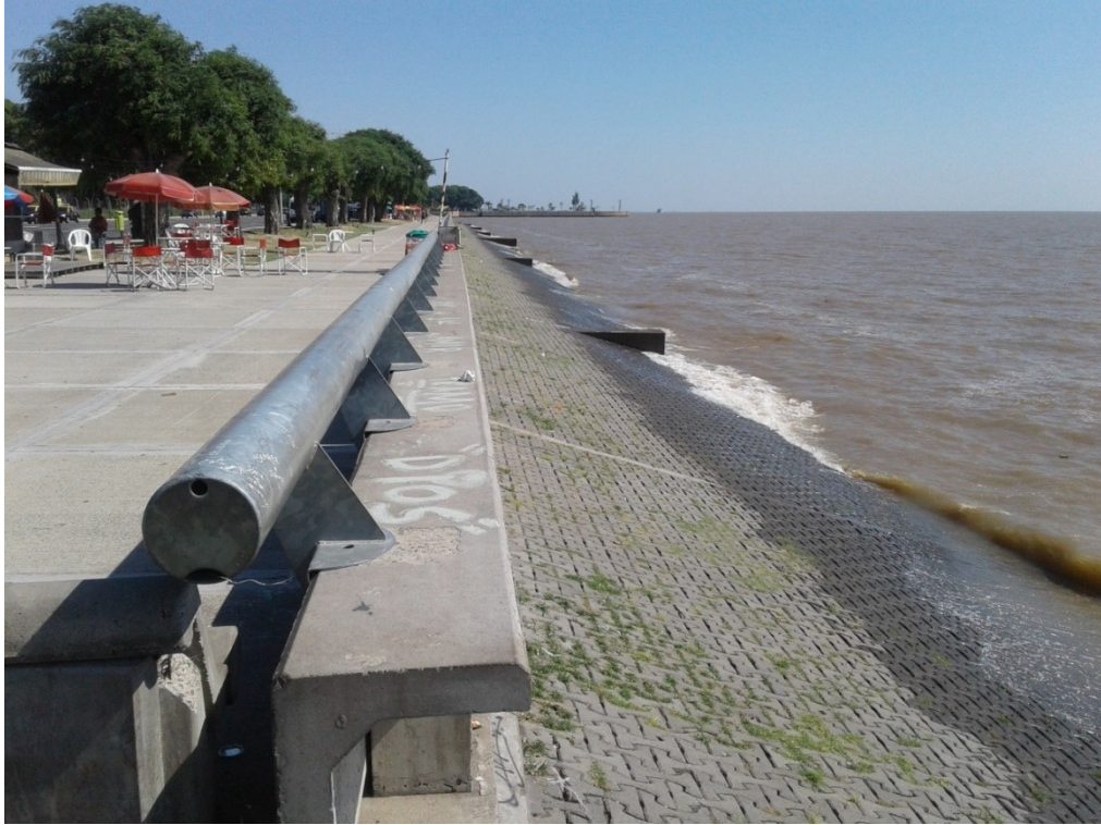
Figura 4. Zona con presencia de talud protegido
