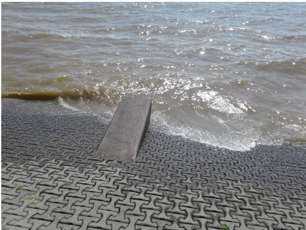
Figura 5. Detalle del talud protegido
