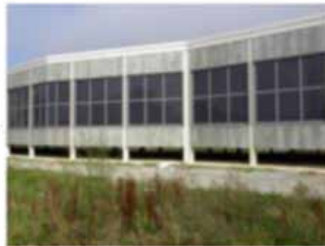
Muro cortina 50 Módulos I-106 P : 5,3 kWp.
