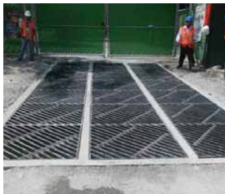
Fig. 22: Estabilización de salida de vehículos - Lavado de Ruedas
