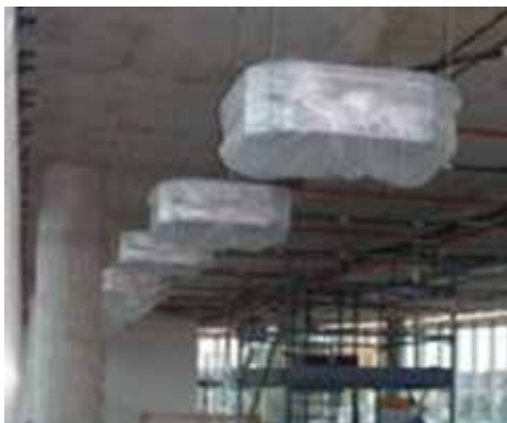
Fig. 46: Tapar conductos de aire acondicionado y equipos hasta la puesta en marcha
