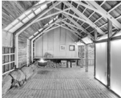
Fig. 61: Cobertizo para Botes. , TYIN Tegnestue: La madera de la vieja edificación es reutilizada como recubrimiento interior de los muros. Los marcos de las ventanas se obtuvieron de una granja en las cercanías
