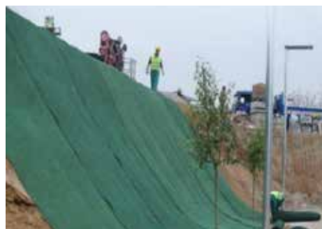
Fig. 11: Manta de control de erosión en pendientes Fuente: Manual estabilización Taludes-Universidad Cordoba, España
