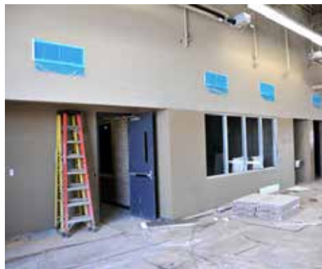
Fig. 45: Tapar conductos de aire acondicionado existentes Fuente: https://firestation219.wordpress.com/
