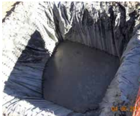
Fig. 23: Estanque de acumulación de hormigón Fuente: Elaboración Propia- YPF ND- Hampton Rivoira Arqs
