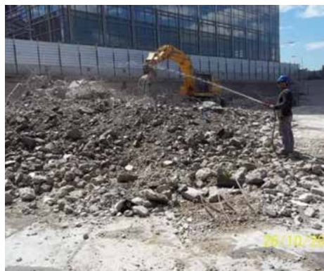
Fig. 36: Riego de residuo para evitar la acción del viento
