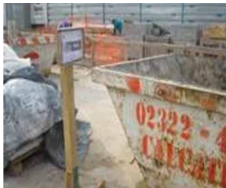
Fig. 35: Contenedores para evitar erosión de residuos
