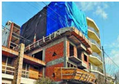
Fig. 30: Protección de emanación de polvo
