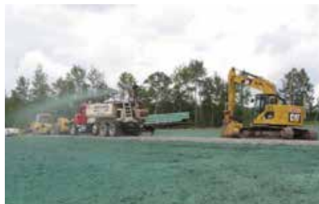
Fig. 9: Siembra temporal Fuente: http://water.epa.gov/polwaste/npdes/swbmp/Seeding.cfm
