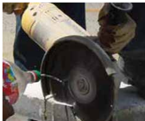
Fig. 39: Control de polvo durante el corte
