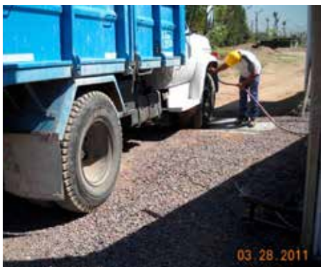
Fig. 21: Estabilización de salida de vehículos - Lavado de Ruedas
