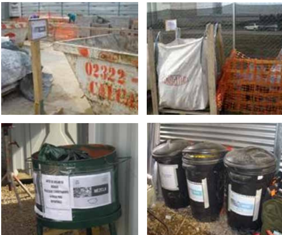
Fig. 63: Separación de residuos en la construcción
