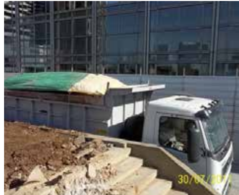
Fig. 33: Protección de materiales en camiones
