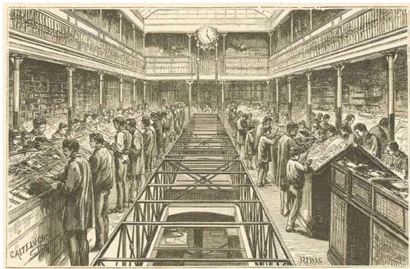
Vista del interior de la imprenta de N. Ramírez y Cía. a fines de siglo XIX, en la sección de cajistas. Nótese el entrepiso superior, el techo vidriado y el nivel inferior para la maquinaria.
