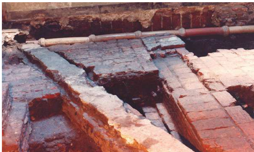
Imagen en la que se incluyen los tres sistemas constructivos superpuestos en el tiempo: la columna de hierro de Coni y los cimientos de ladrillos de dos tipos diferentes de las casas precedentes.
