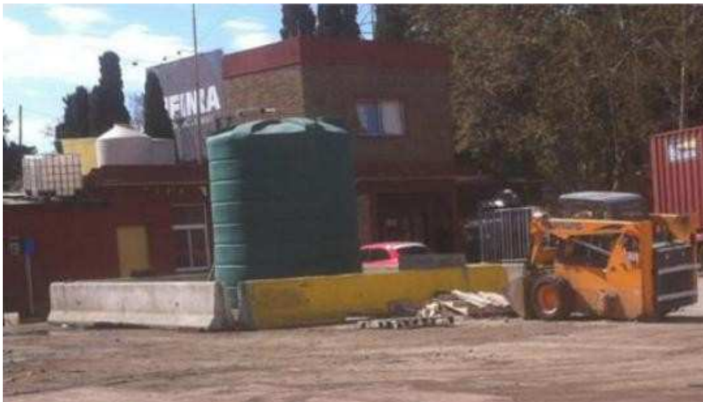
Ilustración 33: Tanque aéreo de gasoil actualmente en uso
