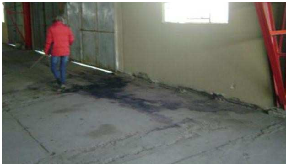
Ilustración 25: Mancha en depósito de surtidores
