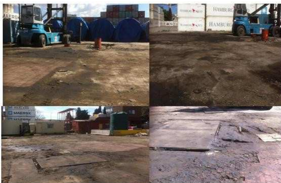
Ilustración 34: Manchas de hidrocarburos en las inmediaciones del tanque de GO
