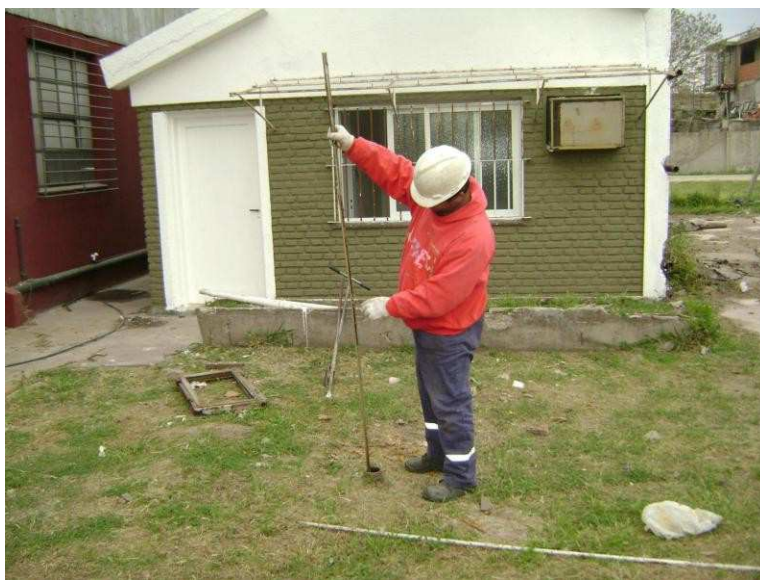
Ilustración 27: Revisión SASH 1,5 m3
