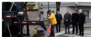
Nuevos camiones bacheadores Permitirán reparar baches en 20 minutos
