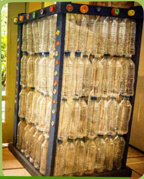
Con estructura de madera y botellas
