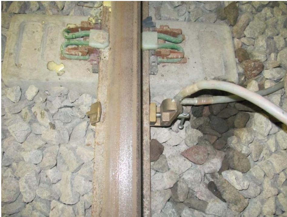
Fig. 6: colocación de morseto para vía
