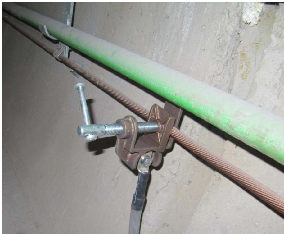
Fig. 5: morseto para puesta a tierra
