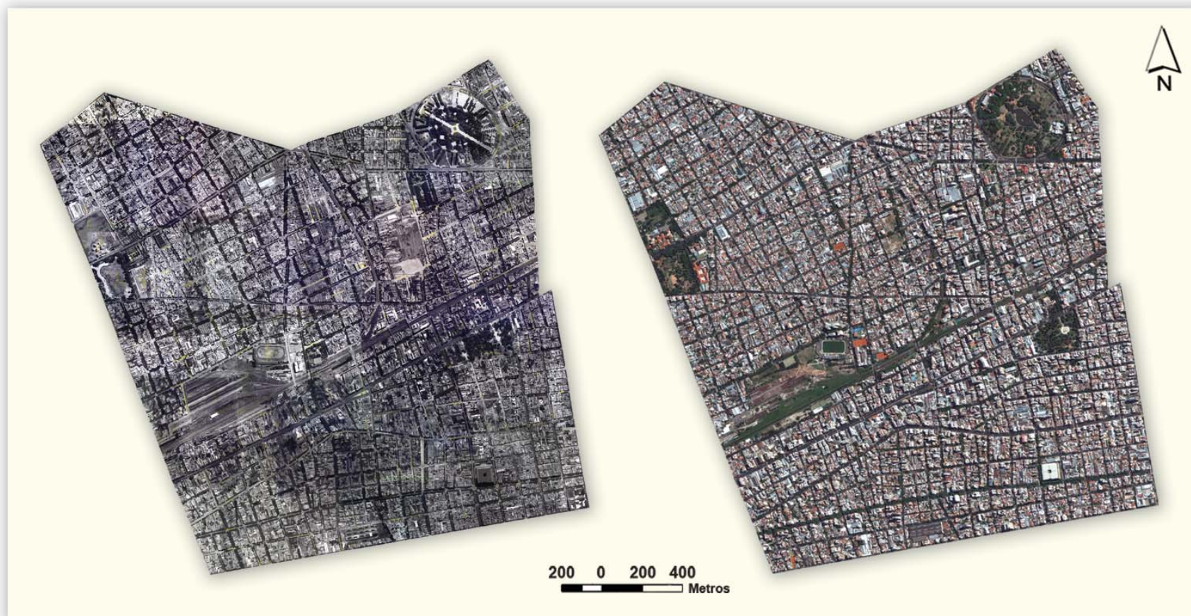
■ Foto área de 1940. En ella se puede ver la estructura consolidada. Se aprecia una menor densidad edilicia y la presencia de algunos lotes de grande dimensiones. Imagen satelital de alta resolución de Caballito de 2004. Se evidencia una mayor densidad constructiva y una mayor ocupación de los espacios. ■
