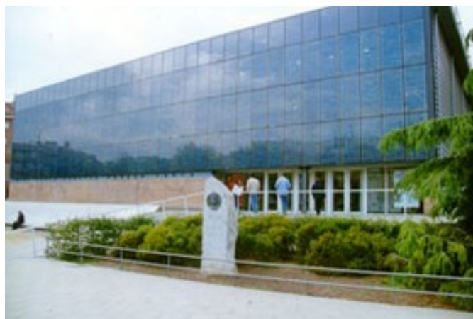
Figura 8: La Biblioteca de Mataró no solo integra FV en el techo y en la fachada, sino también utiliza el aire caliente generado en la parte posterior de los módulos para contribuir a la calefacción en invierno.
