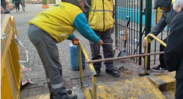
Colocación de baranda en rampa
