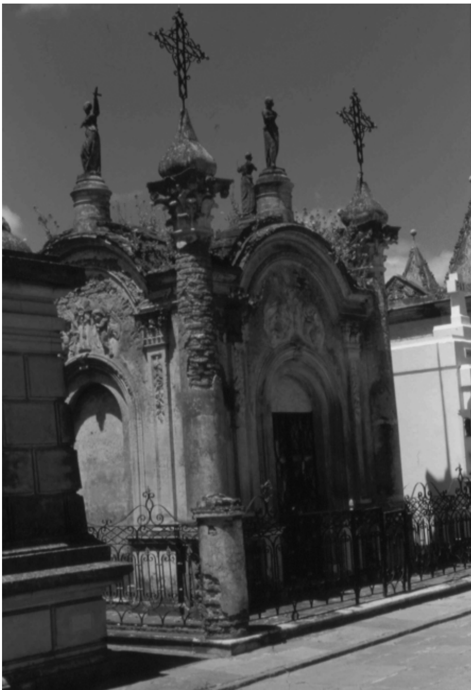
Fig. 2 Bóveda época “revival”
