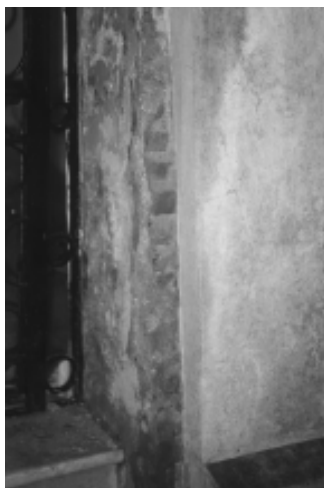
Revoques faltantes y fisuras en muros exteriores
