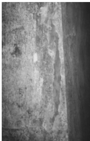
Revoques faltantes y fisuras en muros exteriores
