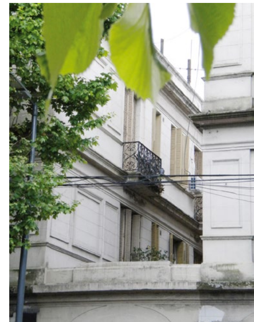
Detalle de la fachada. Foto GNTC.
