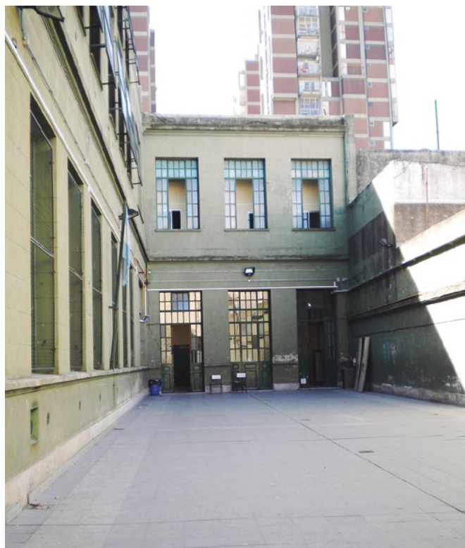
Patio del Normal N° 11. Al fondo se observan las torres del Conjunto Rioja, foto: GNTC.
