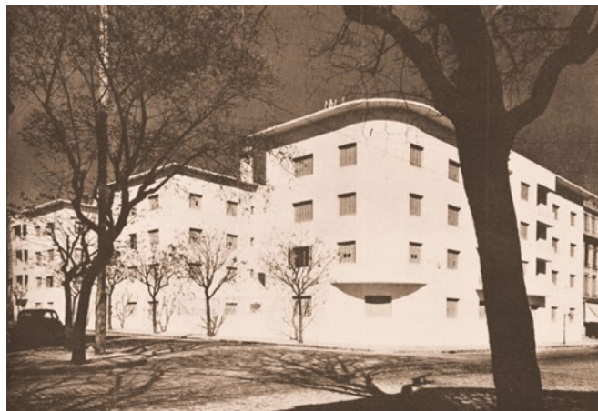
Vista de las fachadas de la Casa Colectiva Patricios, de 24 de Noviembre y Rondeau. Foto: Revista Nuestra Arquitectura N° 124, noviembre 1939, Buenos Aires.
