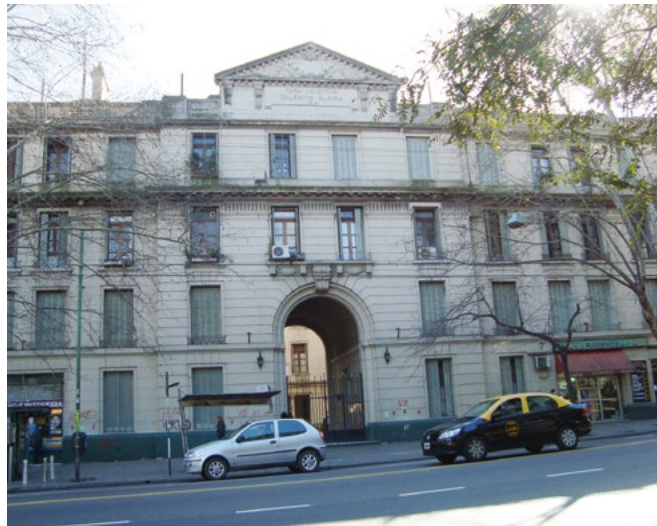
La Casa Alsina en la Av. Caseros 3171/95. Foto GNTC.
