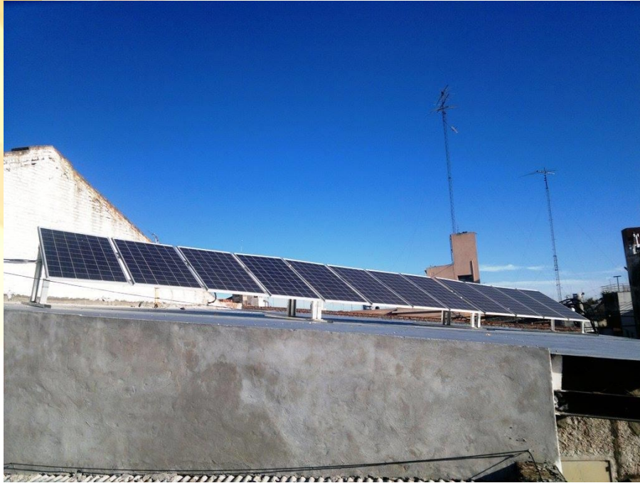
Instalación en la Cooperativa de Luz y Fuerza de Rojas, Provincia de Buenos Aires – 2,88 kWp
