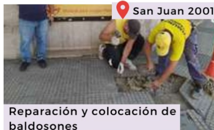
Reparación y colocación de baldosones
