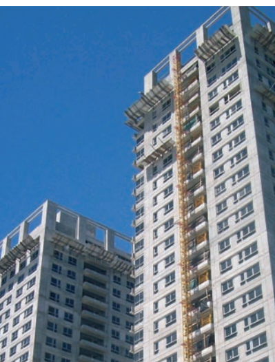
Proceso de construcción de edificios de vivienda.
