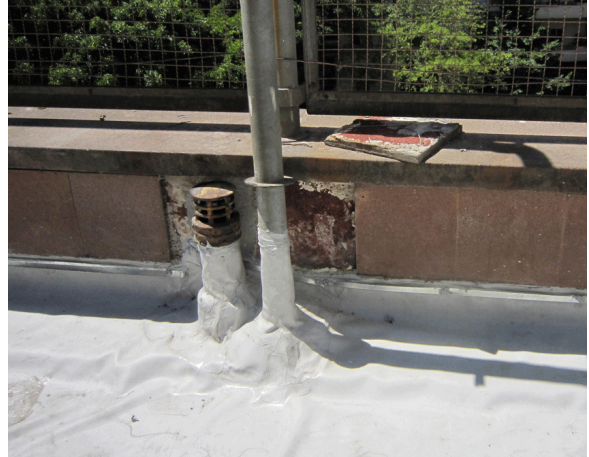
Tareas de impermeabilización con membrana de pvc. Detalles de encuentros con membrana asfáltica y de pvc, según el caso
