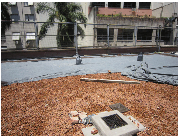
Colocación de segunda capa de manto geotextil
