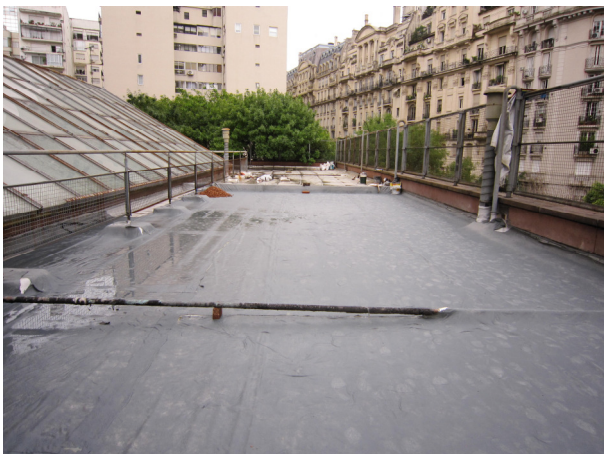
Colocación de manto geotextil
