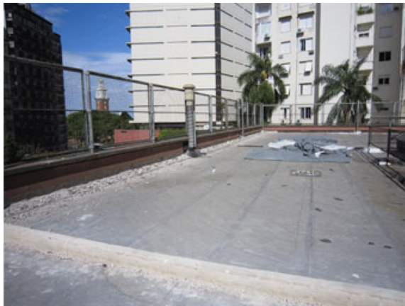
Construcción de muretes de borde
