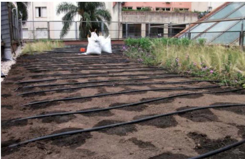
Sistema de riego por goteo
