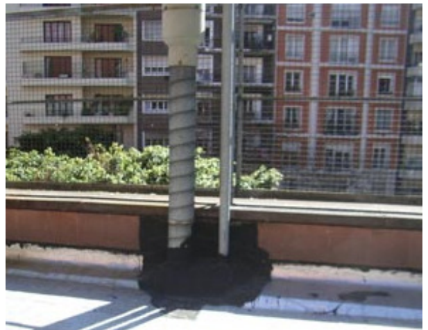
Detalle de borde exterior con babeta perimetral impermeable.
