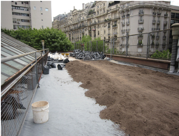
Colocación de sustrato
