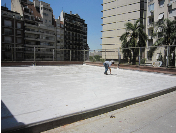
Tareas de impermeabilización con membrana de pvc. Detalles de encuentros con membrana asfáltica y de pvc, según el caso
