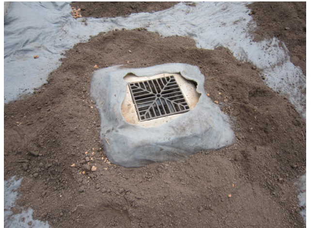
Detalle de sector rejilla, manto geotextil y sustrato
