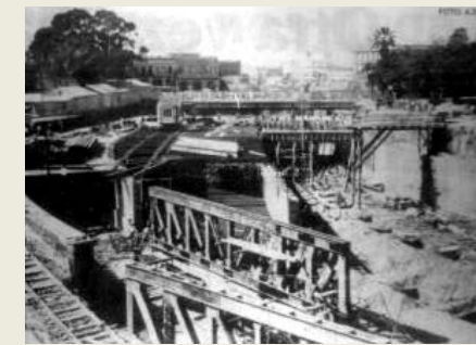
Parte del túnel excavado a cielo abierto.
